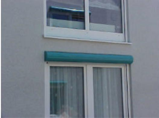
Das Aluminium-Gehäuse des Rolladenkastens ist mechanisch durch ein Stecksystem in den Führungsschienen befestigt. Außen wird er – mit zwischenliegendem Dichtband - eingeputzt. Das Rolladensystem ist in der Meinung der Allgemeinheit thermisch besser, da es außen vor der Konstruktion aufgebaut wird.
